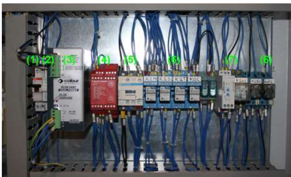
Fig. 3.17 – Circuito Ausiliari 24V
